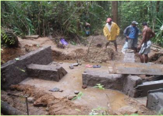
4-Meter -Staumauer in Ambodiforaha (Ende Juli)
