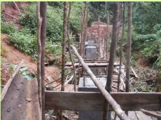
27-Meter-Speicherbrücke von Manambia (Ende Juli)
