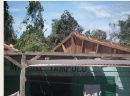
Beschädigte Unterbasis der Seeparzelle
