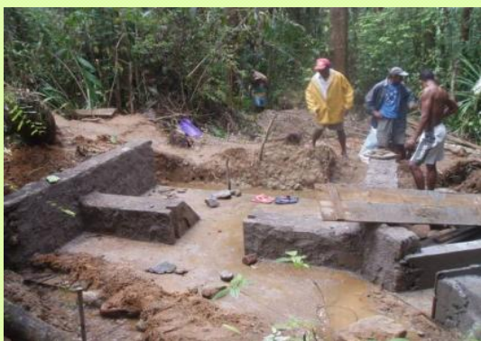
4-Meter -Staumauer in Ambodiforaha (Ende Juli)
