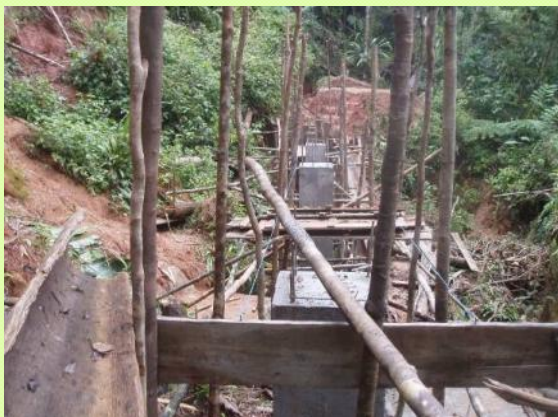
27-Meter-Speicherbrücke von Manambia (Ende Juli)
